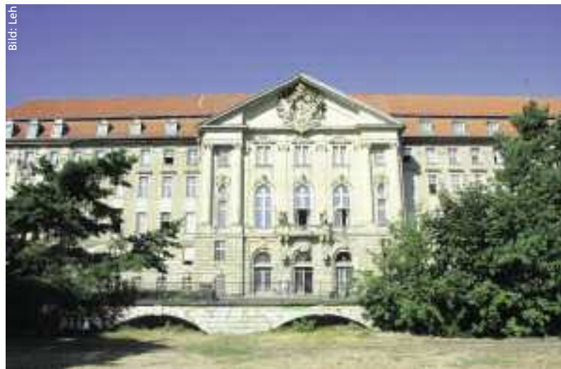
Kammergericht: Parkseitige Prunkfassade mit Haupteingang
