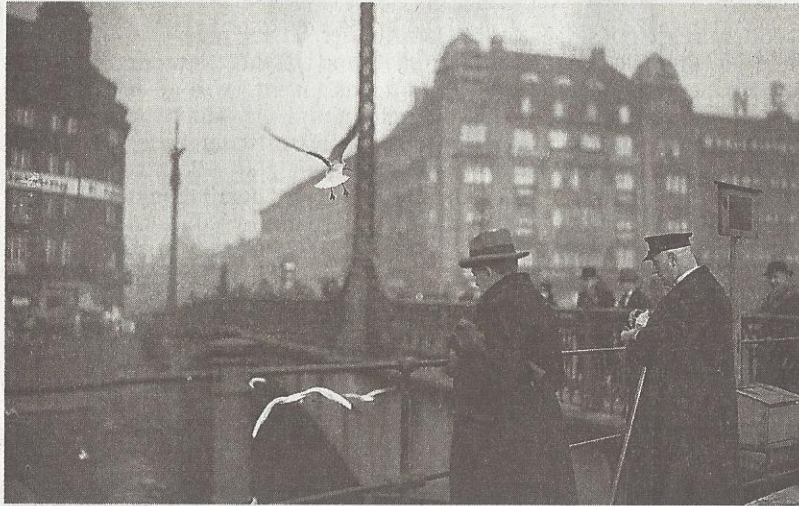
Die Weidendammer Brücke, die noch heute über die Friedrichstraße führt.
